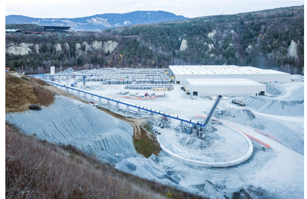
Beispiel Förderbandanlage für den Brenner Basistunnel 2017-2022
